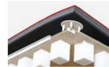
Detail Schwingboden und Rollbahnen
